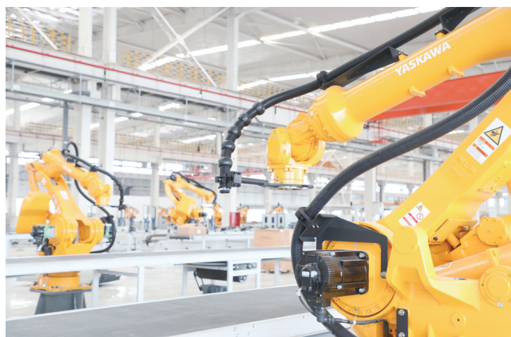
下料中心等离子线小件二次分拣区机器人安装完成
